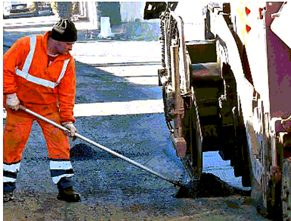
CANTIERI Alcuni lavori di riasfaltatura in un'immagine di repertorio
